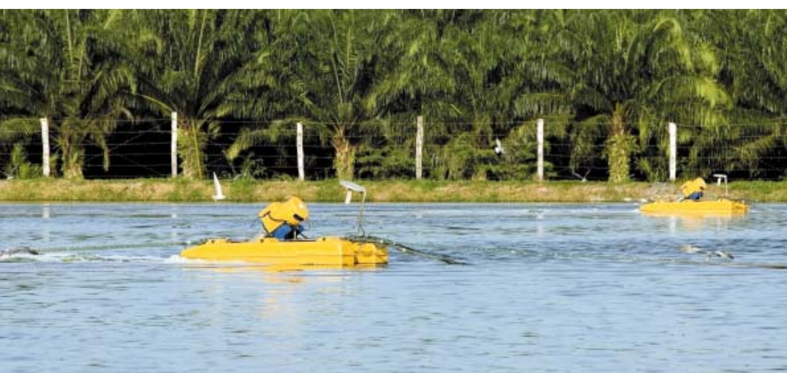
Aerobic Effluent Pond
